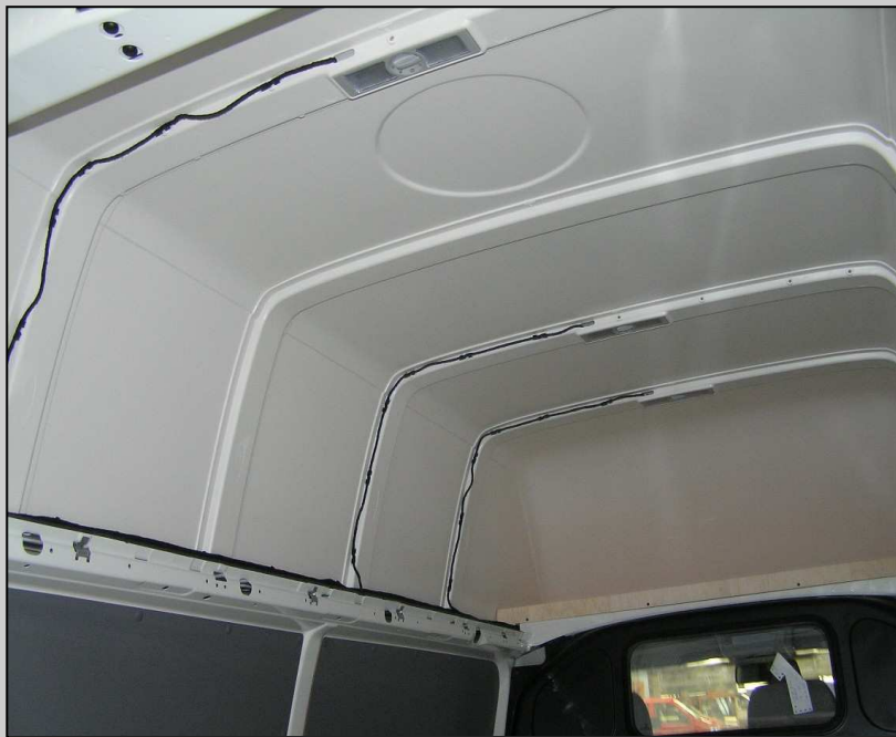
heute (Kabel sichtbar)
